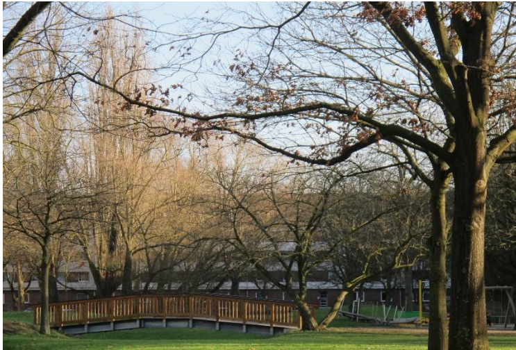
Erneuerung Wege, Rundweg, Brücke
